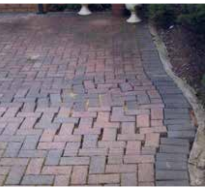
Poor edge restraint
